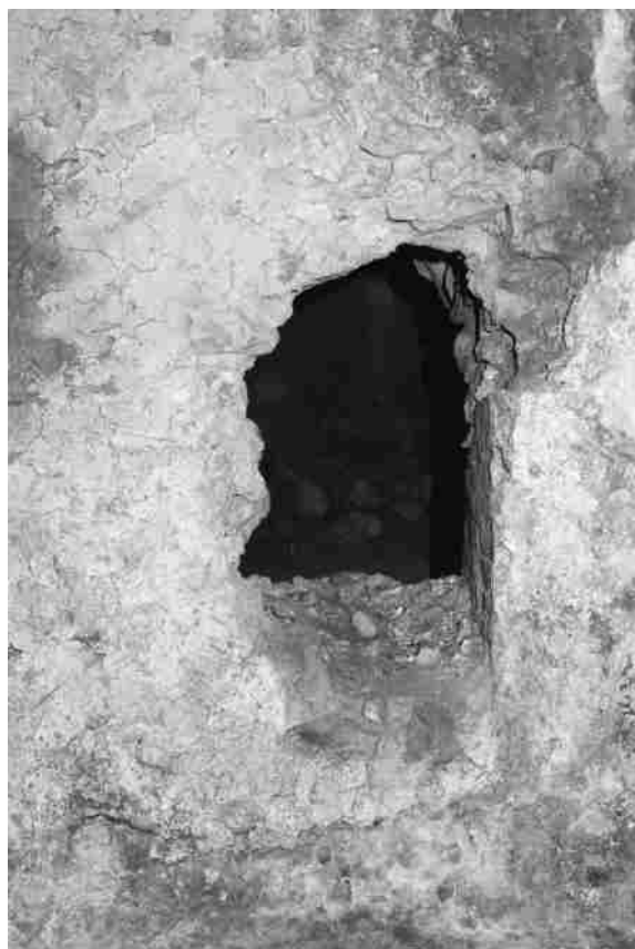
Figura 8 - Vano di passaggio ai locali adiacenti
