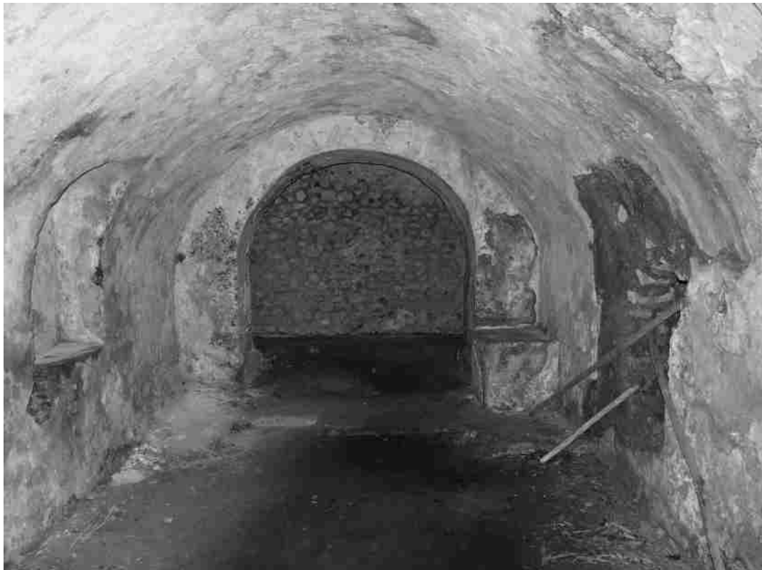
Figura 4 - Interno della chiesa
