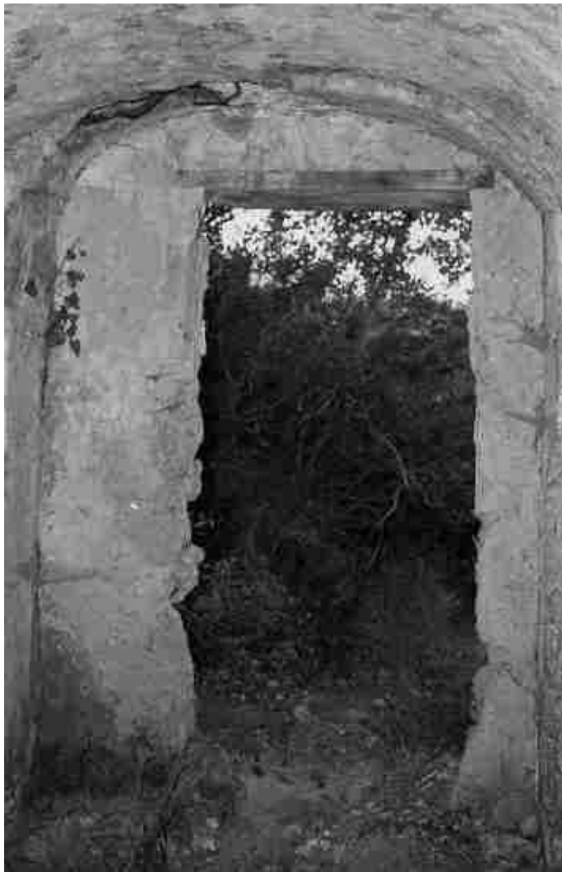
Figura 3 - Attuale vano di accesso
