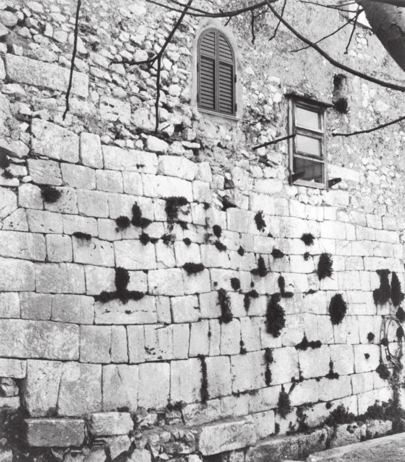
Un tratto delle mura preromane
