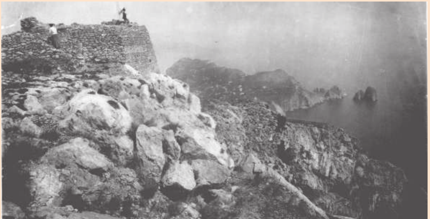
Fortino di monte Solaro (oggi stazione superiore della seggiovia).
