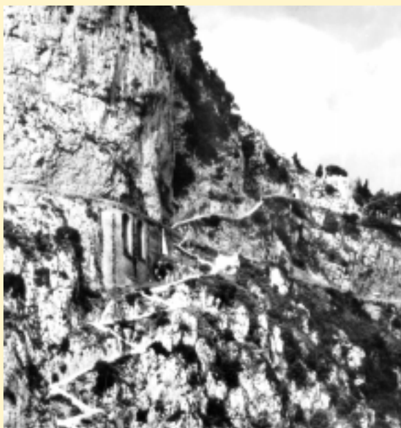
La Scala "Fenicia" cominciava in località Palazzo a Mare (Marina Grande) e s'inerpicava ripida fino ad Anacapri, terminando, in località Capodimonte, con la porta fortificata della cittadina. Oggi, restaurata, è ancora perfettamente percorribile.
